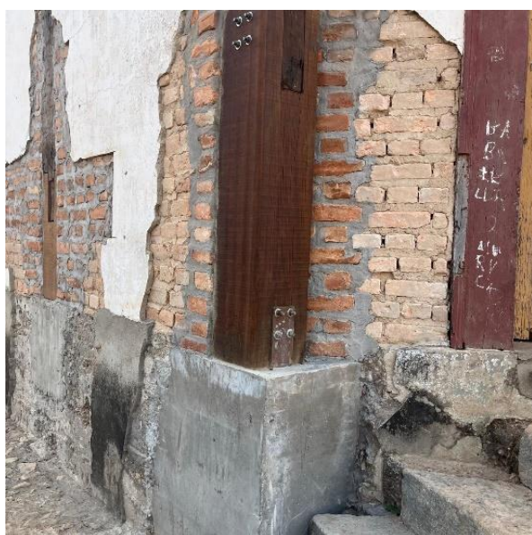
Reforço estrutural externo. Autoria: Eduardo Santos Data:03/09/2024
