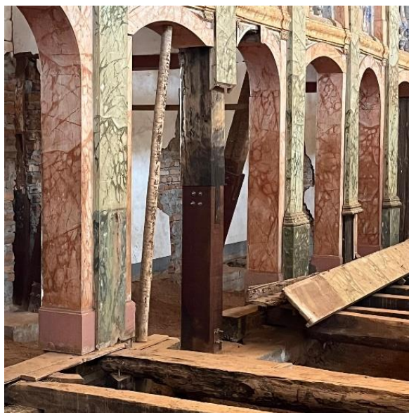
Reforço estrutural em esteio interno. Autoria: Eduardo Santos Data:03/09/2024
