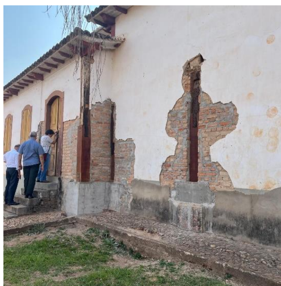
Vista lateral da igreja com reforços estruturais Autoria: Eduardo Santos Data:03/09/2024
